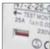
kontrolka sygnalizująca zadziałanie
